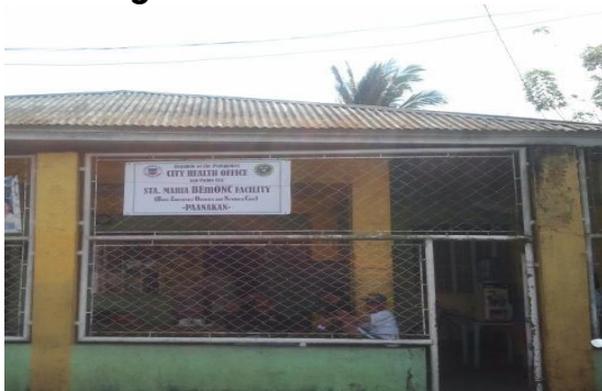
Figure 32. Sta. Maria BEMONC Facility
